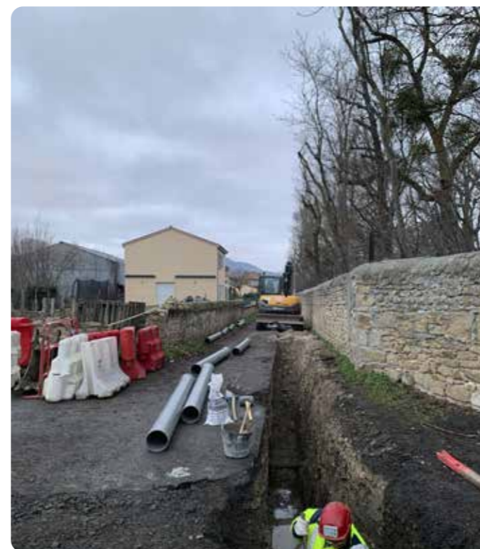
Pose de la canalisation d'eaux usées
