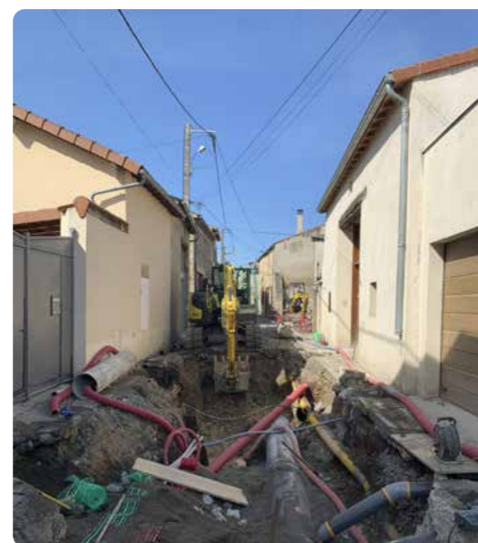
Pose des canalisations
