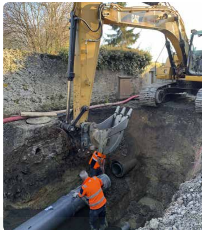
Pose des canalisations
