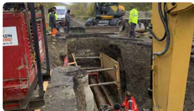
Fonçage sous le Charlet pour passer le collecteur d'eaux usées de Plauzat
