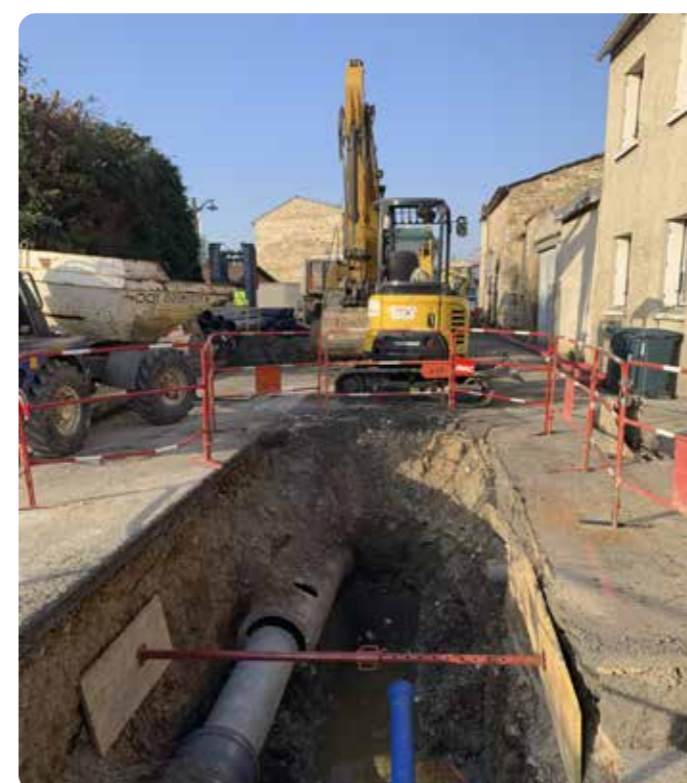
Pose des canalisations
