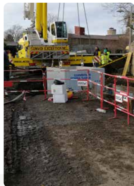
Fonçage sous le Charlet pour passer le collecteur d'eaux usées de Plauzat
