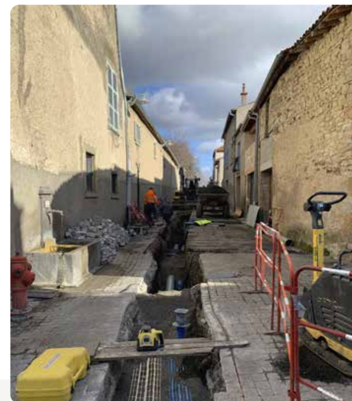
Pose de la canalisation d'eaux usées
