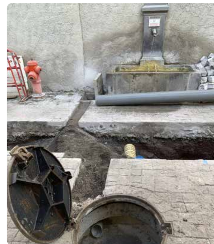
Raccordement de la fontaine au réseau d'eaux pluviales
