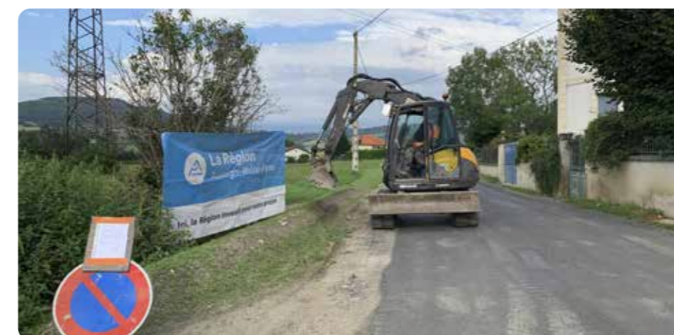
Préparation de la fouille pour l'enfouissement des réseaux secs
