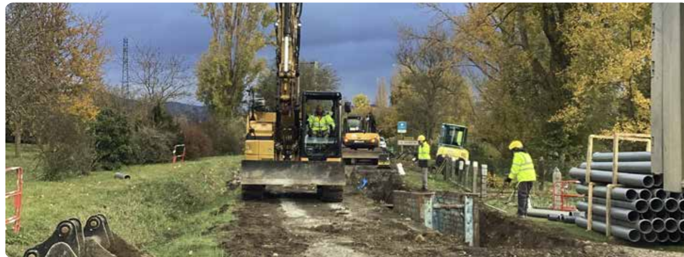
Fin du chantier route de Plauzat.
