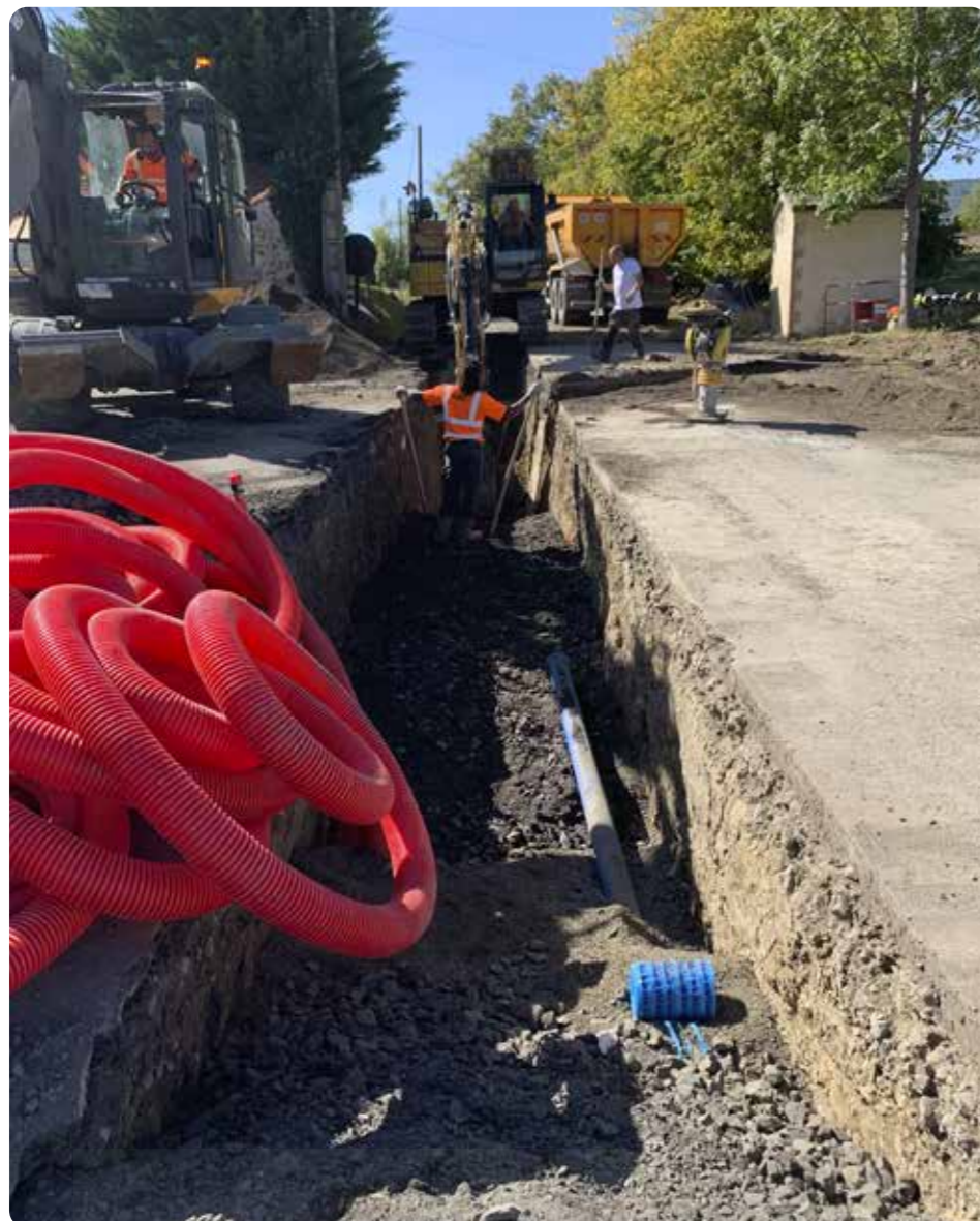
Déroulement des gaines pour l'enfouissement des réseaux
