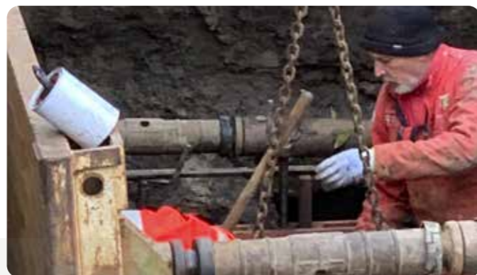
Fonçage sous le Charlet pour passer le collecteur d'eaux usées de Plauzat
