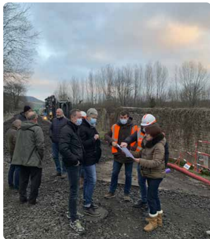
Les élus en réunion de chantier
