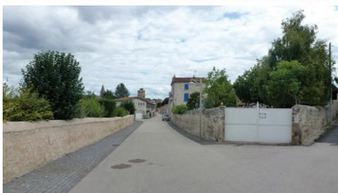
Ces murs de clôture ou de soutènement, de hauteur variable, sont généralement bâtis en moellons jointoyés ou enduits.
