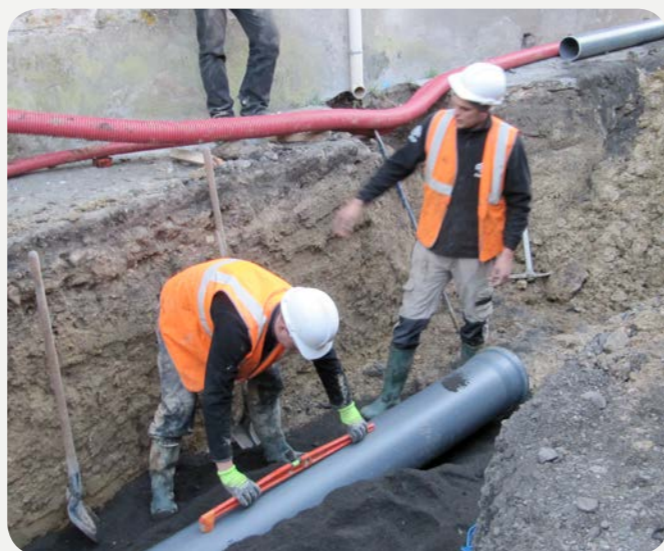
Travaux d'assainissement rue de la Garenne
